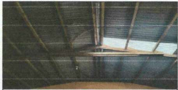
Foto 4: Vista del interior de un aula. Donde se hara el cambio total de las vigas y costaneras las cuales en este momento todas son de madera y se hara el cambio ahora seran de metal.
